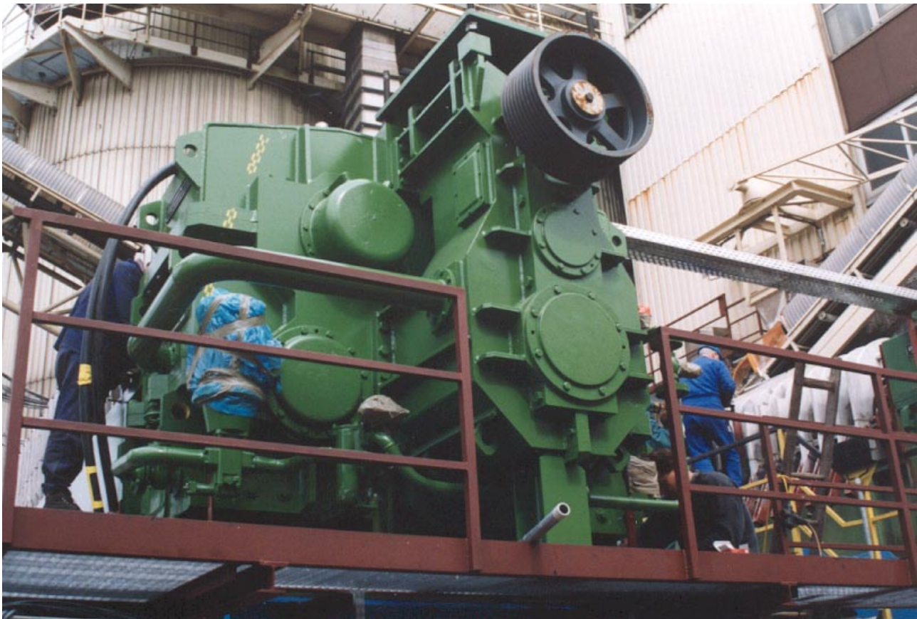
Getriebekombination DP32-K mit Keilriementrieb, Getriebeaufbau durch Ja)(Ke-Servicepersonal Gearbox combination DP32-K with V-belt drive, installation of gearbox by Ja)(Ke service personnel
